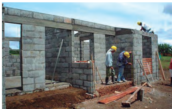
Fotografía: Bariloche Opina
